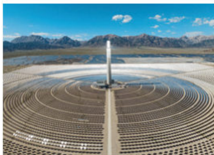
青海德令哈熔盐光热发电项目
