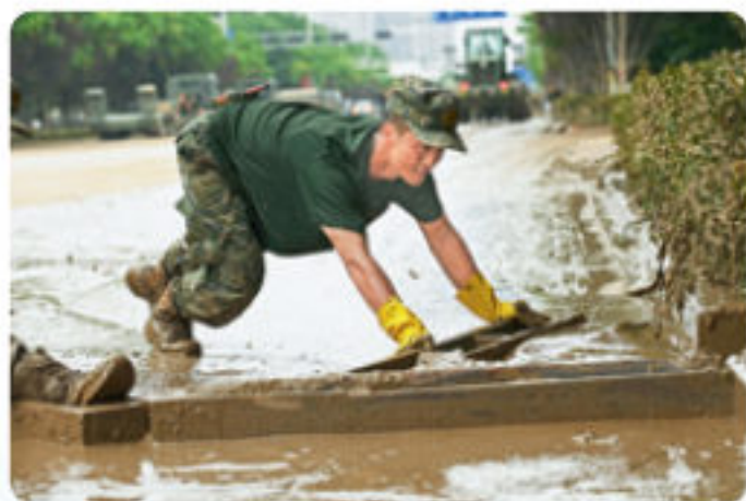
开展清淤作业
