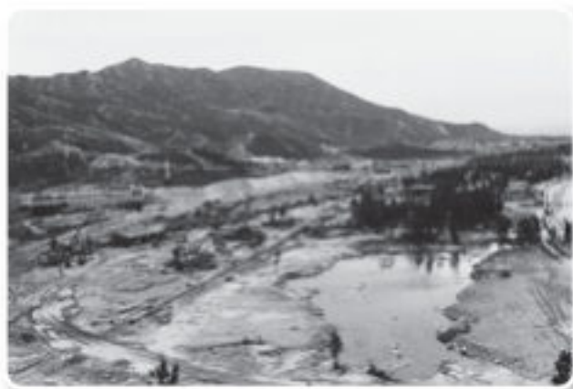
20世纪80年代正在建设中的深圳蛇口工业区
