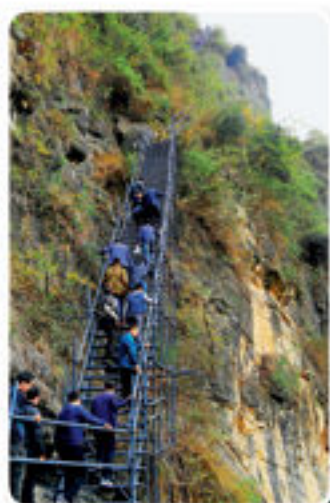
藤梯改建后的钢梯
