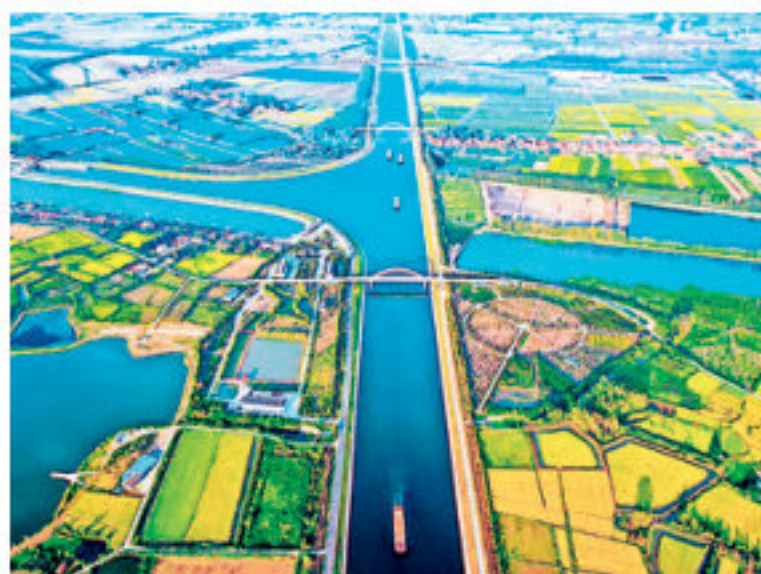
图 3-25 引江济汉工程干渠
