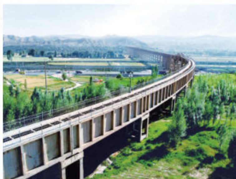
图 3-26 引大入秦工程渡槽
