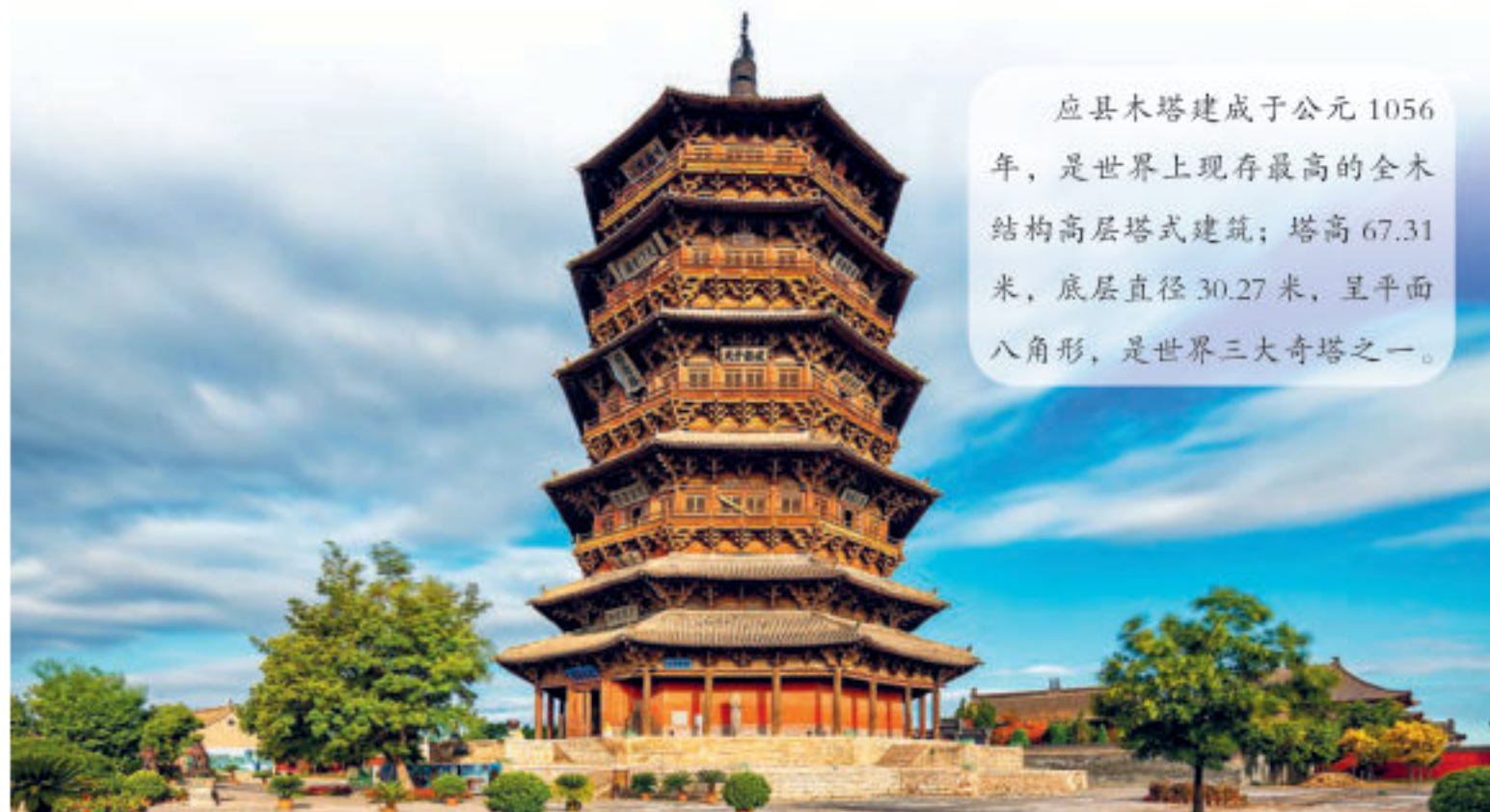
图 5-14 山西应县木塔
