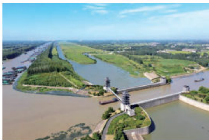
图 5-5 淮安枢纽工程
