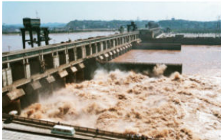
1970年动工兴建的葛洲坝水利枢纽工程
