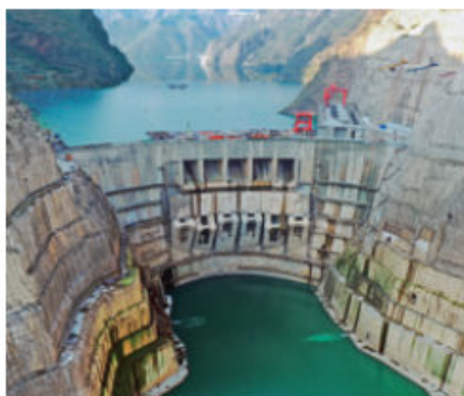
图 11.3-5 乌东德水电站的拦河拱坝
