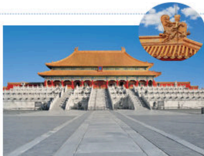
图19.1-7 古建筑上加装的防雷装置
