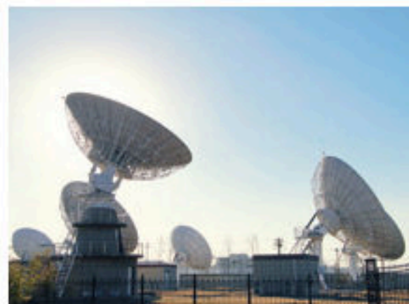
图21.3-1 微波通信接收装置
